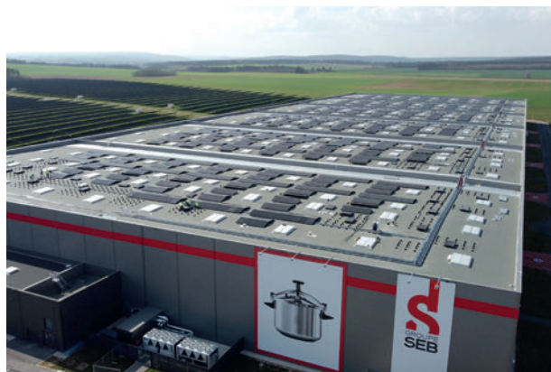
Installation d'une centrale photovoltaïque à Til-Châtel
